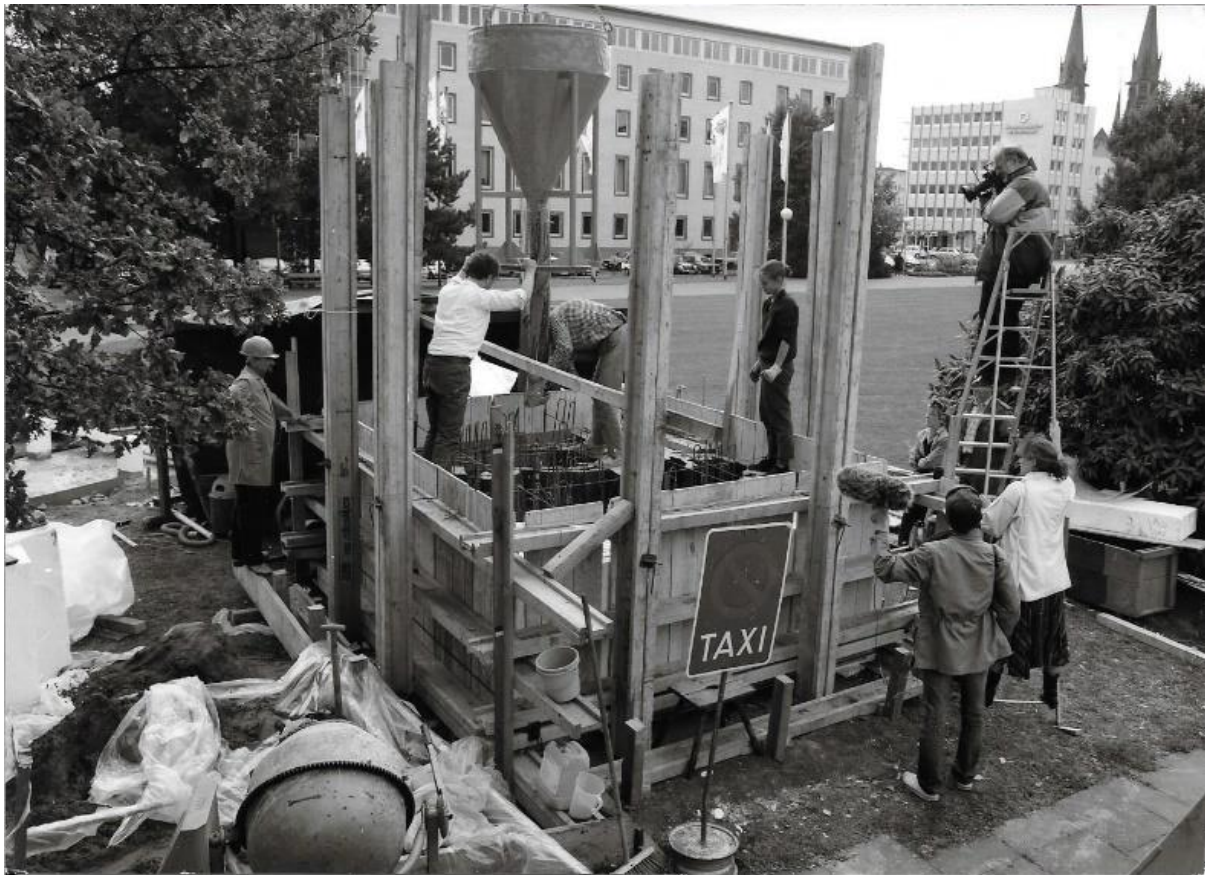
Der Betonguss
